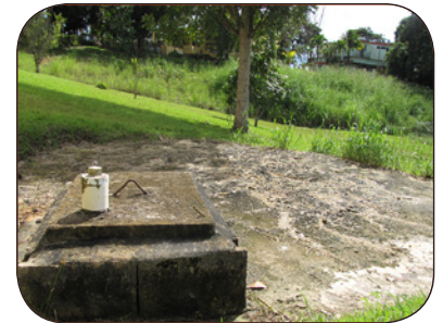
Mantenga el pozo séptico sellado.
